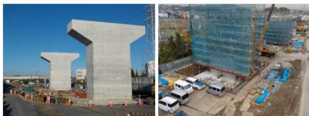
図 1: 建設現場の状況
